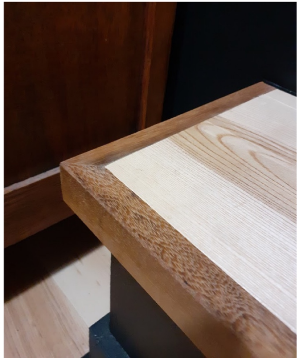
Figure 22: Parement de tablette en Eveuss dans une maison Bruxelloise (Belgique).
