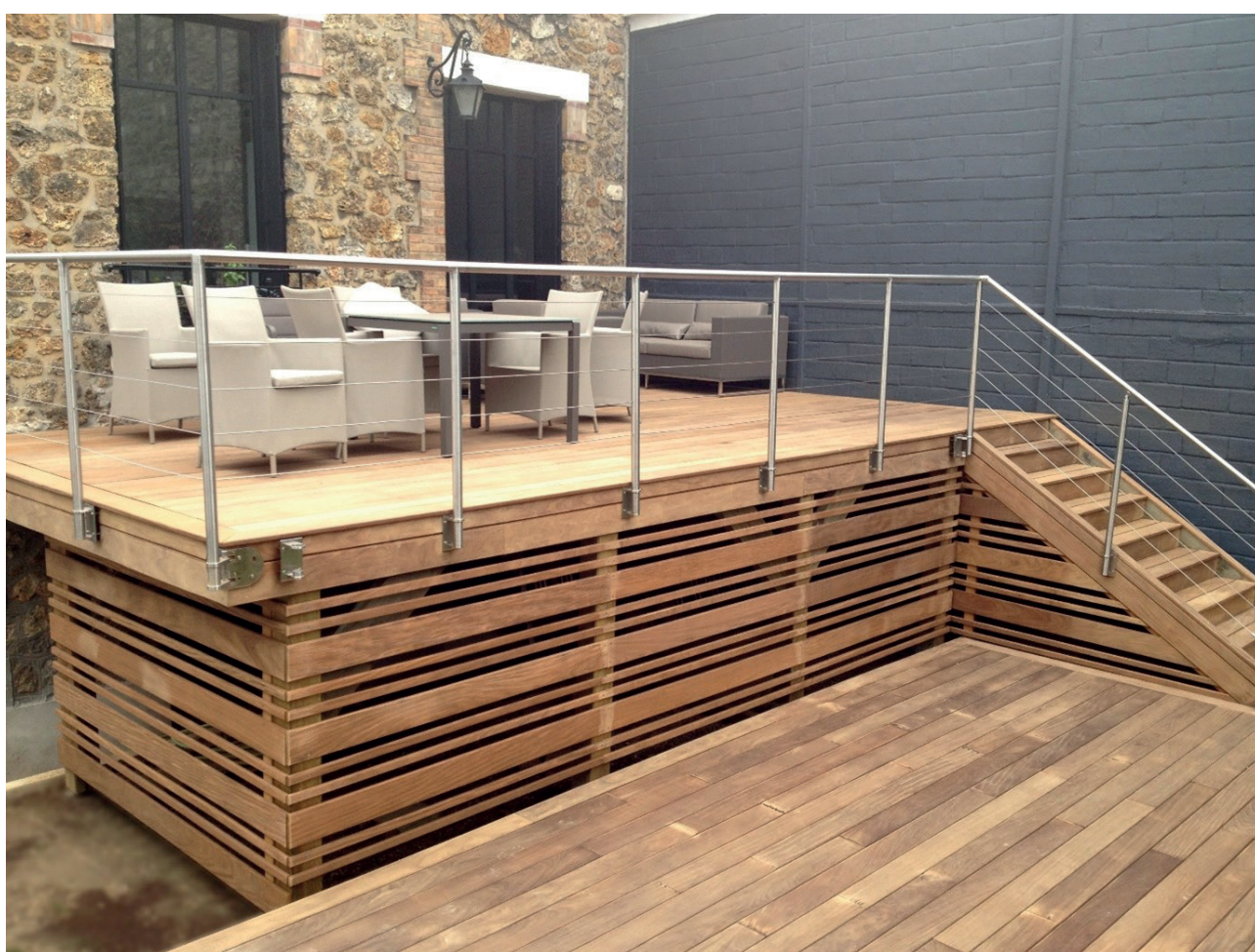
Escalier et platelage surélevé en Afrormosia - Création Terrasse Nature, Antony (France). © Terrasse Nature (photo extraite de l' Atlas des bois tropicaux 2016 )
