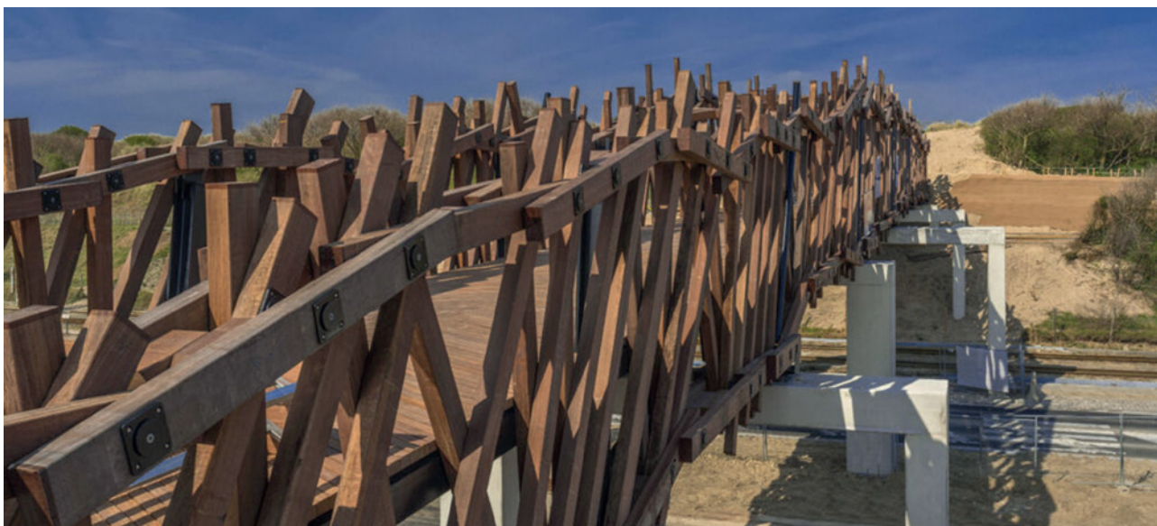
Pont «Het Wrakhout» et son garde-corps (Azobé, Okan and Tali), associés à une piste cyclable et un passage piétonnier – Welduine, Belgique © van Wijma kampen
