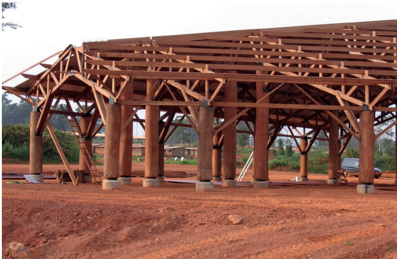
Structure triangulée en Kosipo et poteaux en Tali Réalisation J.-Y. Riaux (Mindourou, Cameroun) © Jean-Yves Riaux ((photo extraite de l'Atlas des bois tropicaux 2016))
