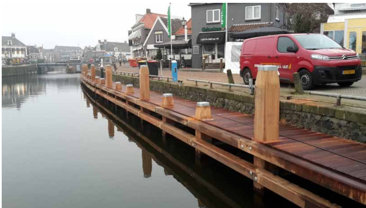
Cheminement de quai en Azobé et Basralocus (Angélique)
