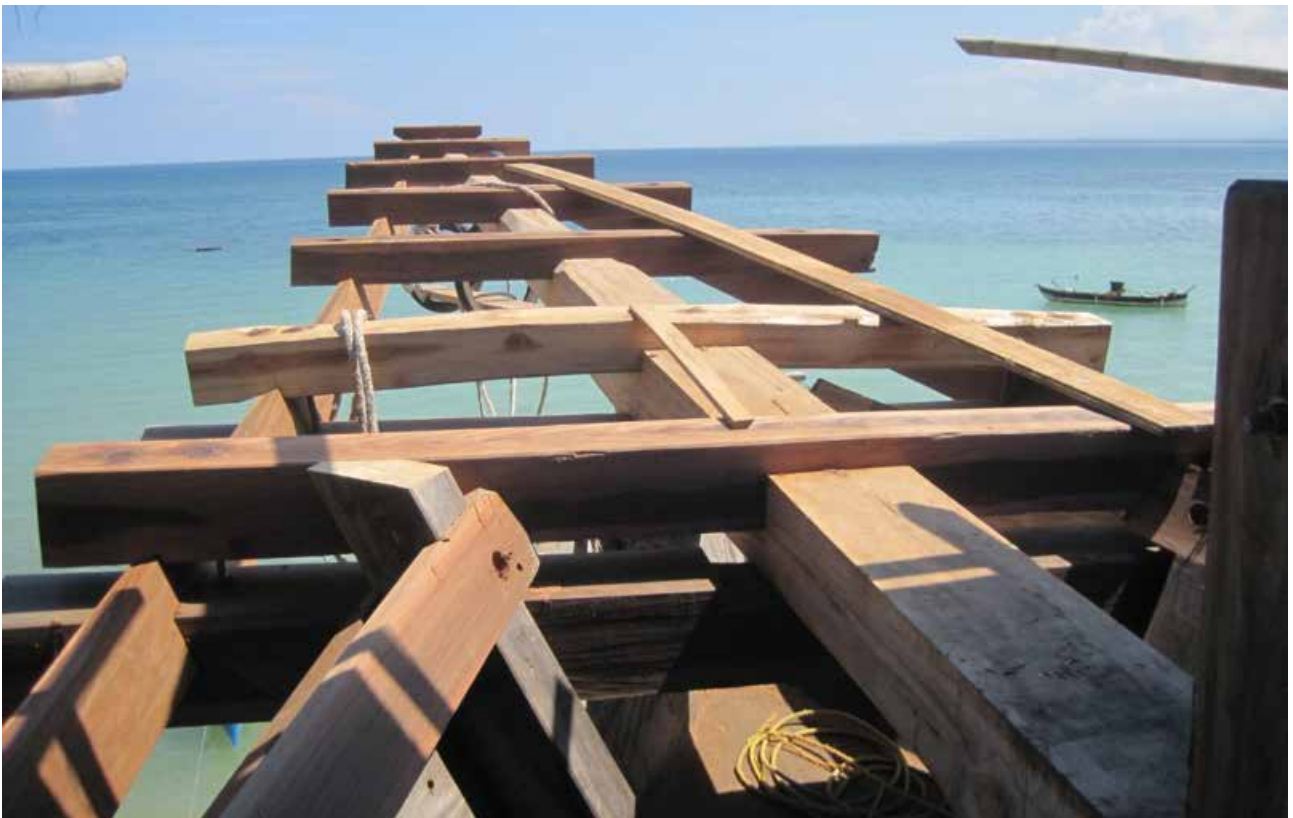
Proue en Bangkirai d'un «perahu pinisi» (Goélette / Schooner) en construction (navire traditionnel de transport domestique de marchandises) - Chantier naval traditionnel Bugis - Bira, Bulukumba, Célèbes du Sud, Indonésie (© Benoît Gomet, France Timber)
